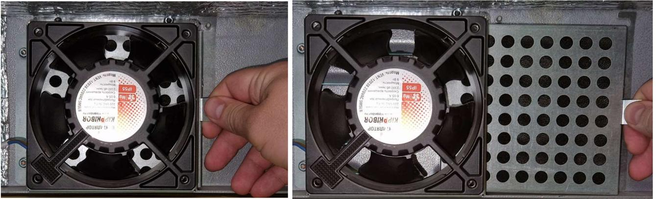
Рис. 89. Кассета фильтра и фильтрующий элемент приточного вентилятора
